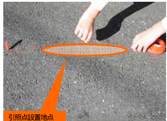
引照点設置地点 チョーク墨出し器によるマーキング
