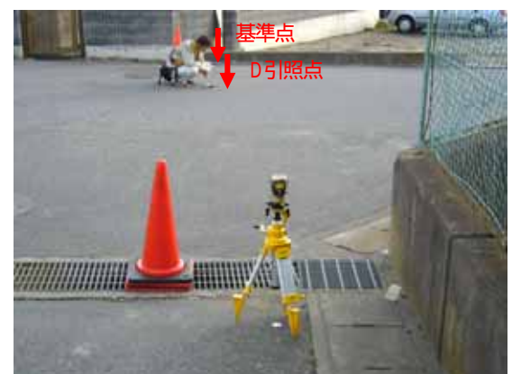
基準点埋設後の点検
