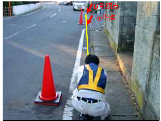
水系を張る(A引照点～基準点～B引照点)
