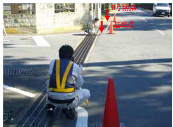
基準点埋設後の点検
