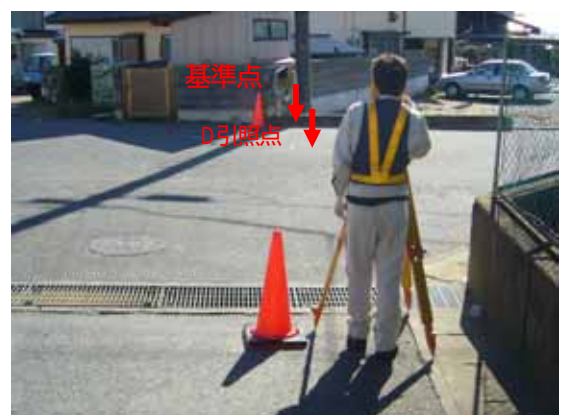
基準点埋設後の点検
