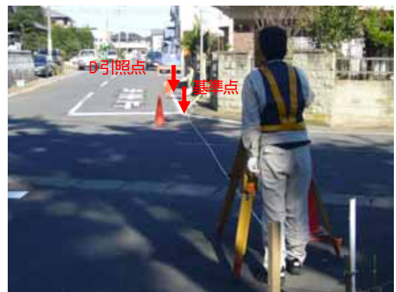
基準点埋設後の点検
