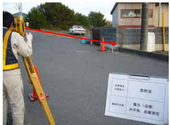
基準点埋設後の点検
