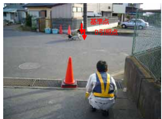
基準点埋設後の点検
