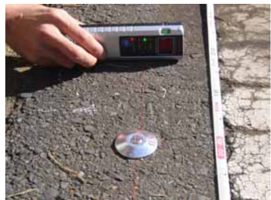
引照点設置後の点検
