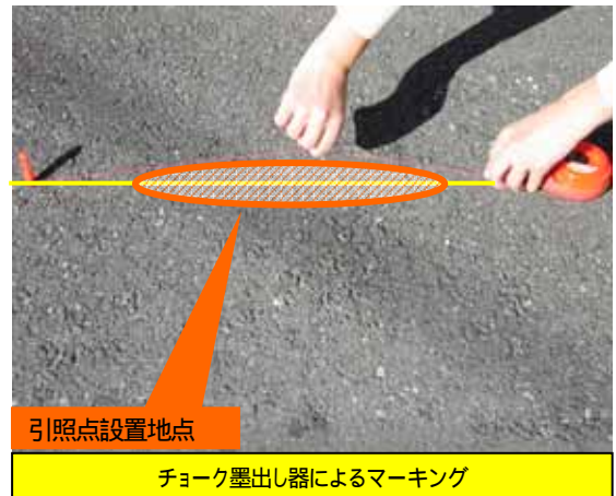
水系を張る(A引照点～B引照点～基準点)
